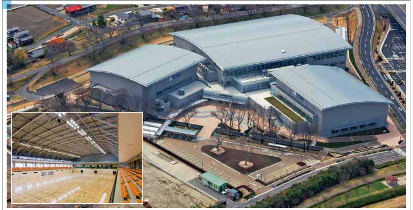
一宮市光明寺公園総合体育館 (工期: 2008/11~2010/12)
