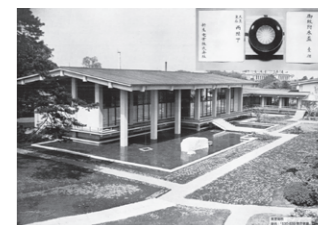
東宮御所新築電気設備工事施工
