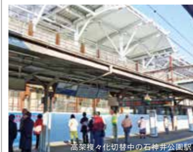
高架複々化切替中の石神井公園駅
