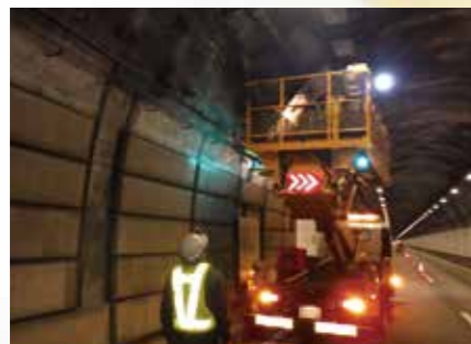
トンネル内LED照明設置工事
