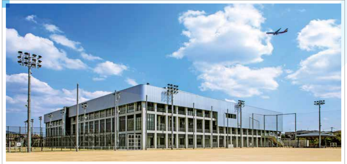
春日市総合スポーツセンター (工期: 2013/09~2015/10)
