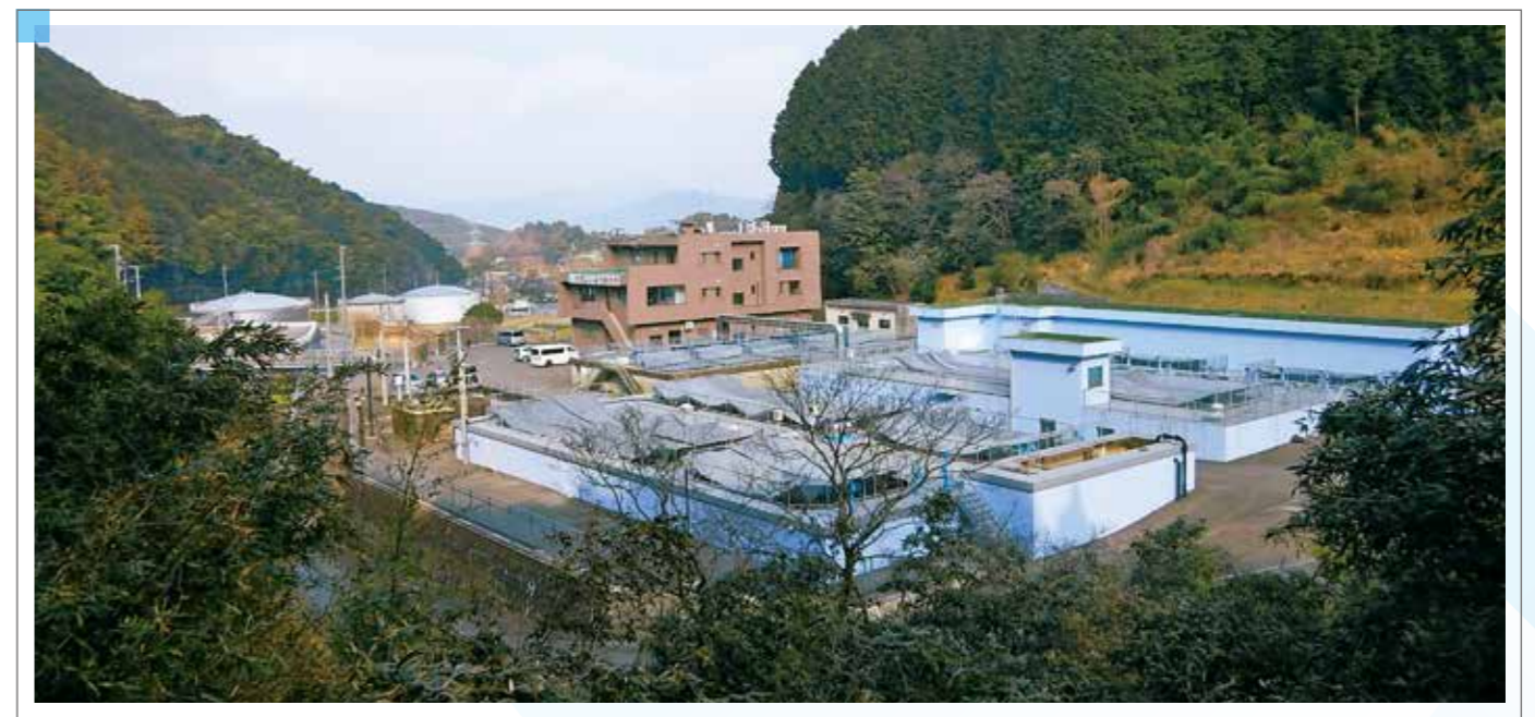
山神水道企業団浄水場 (工期: 2007/10~2013/03)
