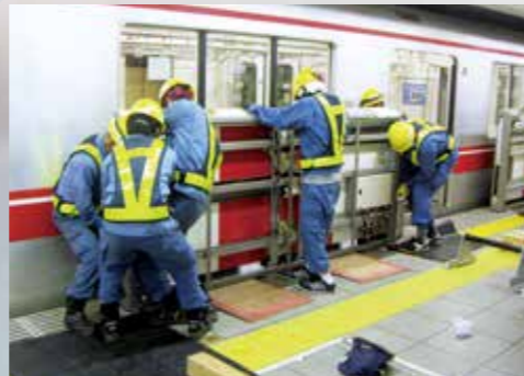
ホームドア据付工事
