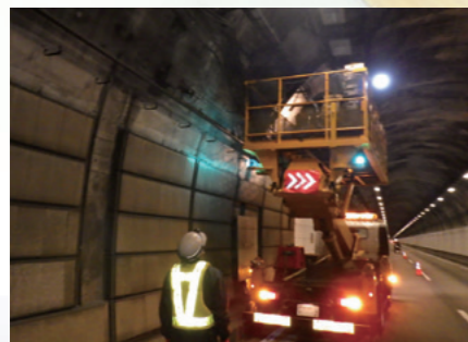
トンネル内LED照明設置工事
