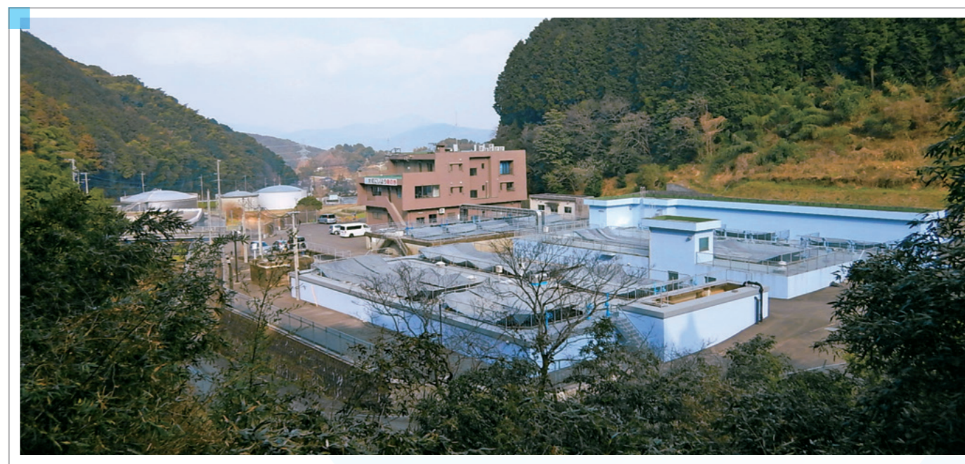
山神水道企業団浄水場 (工期: 2007/10~2013/03)
