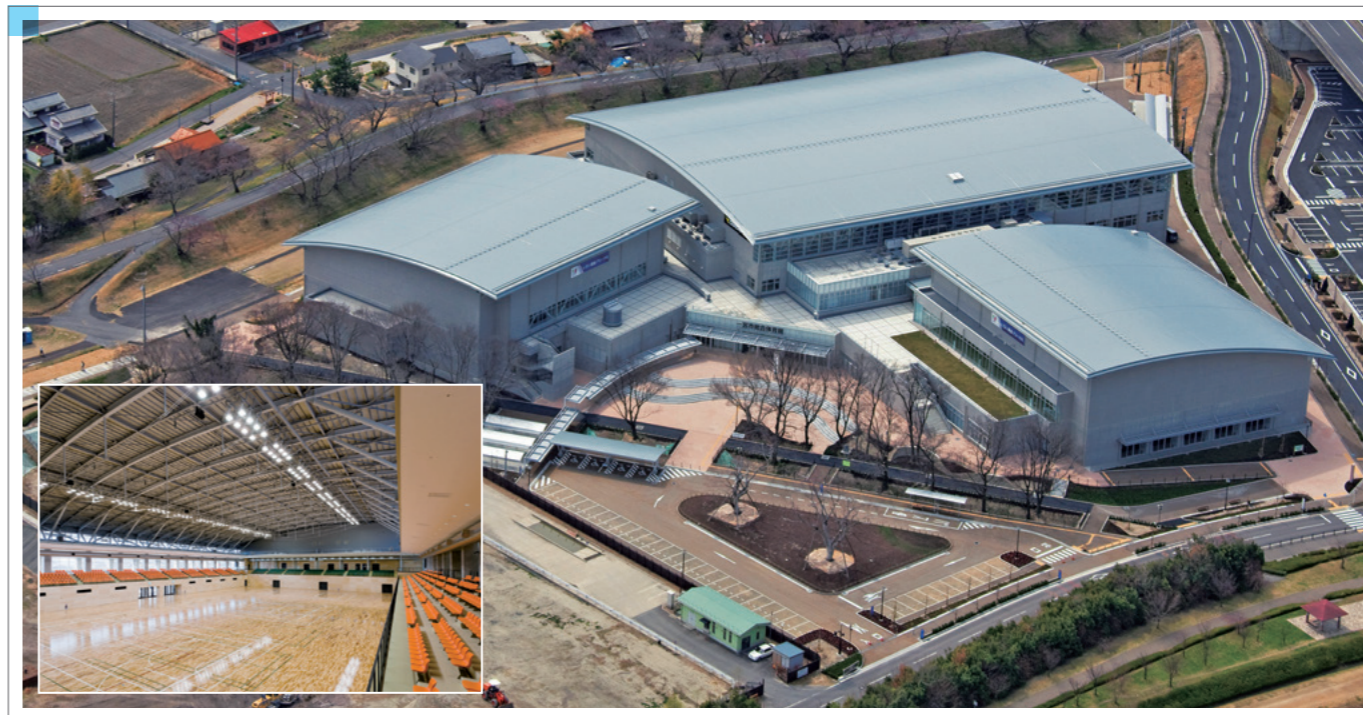
一宮市光明寺公園総合体育館 (工期: 2008/11~2010/12)
