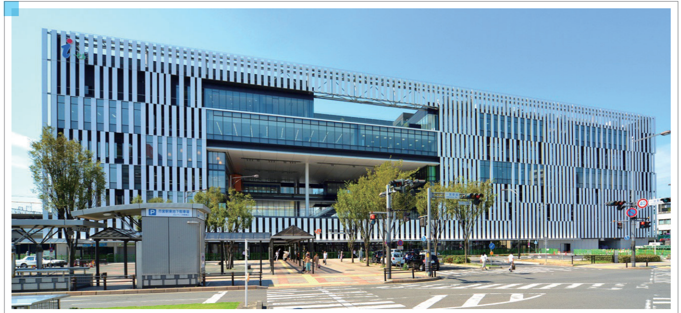
尾張一宮駅前ビル iビル (工期: 2010/10~2012/09)
