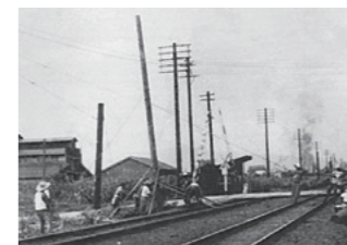
東海道本線草薙・静岡間電化柱建植
