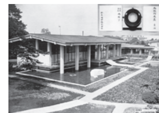
東宮御所新築電気設備工事施工
