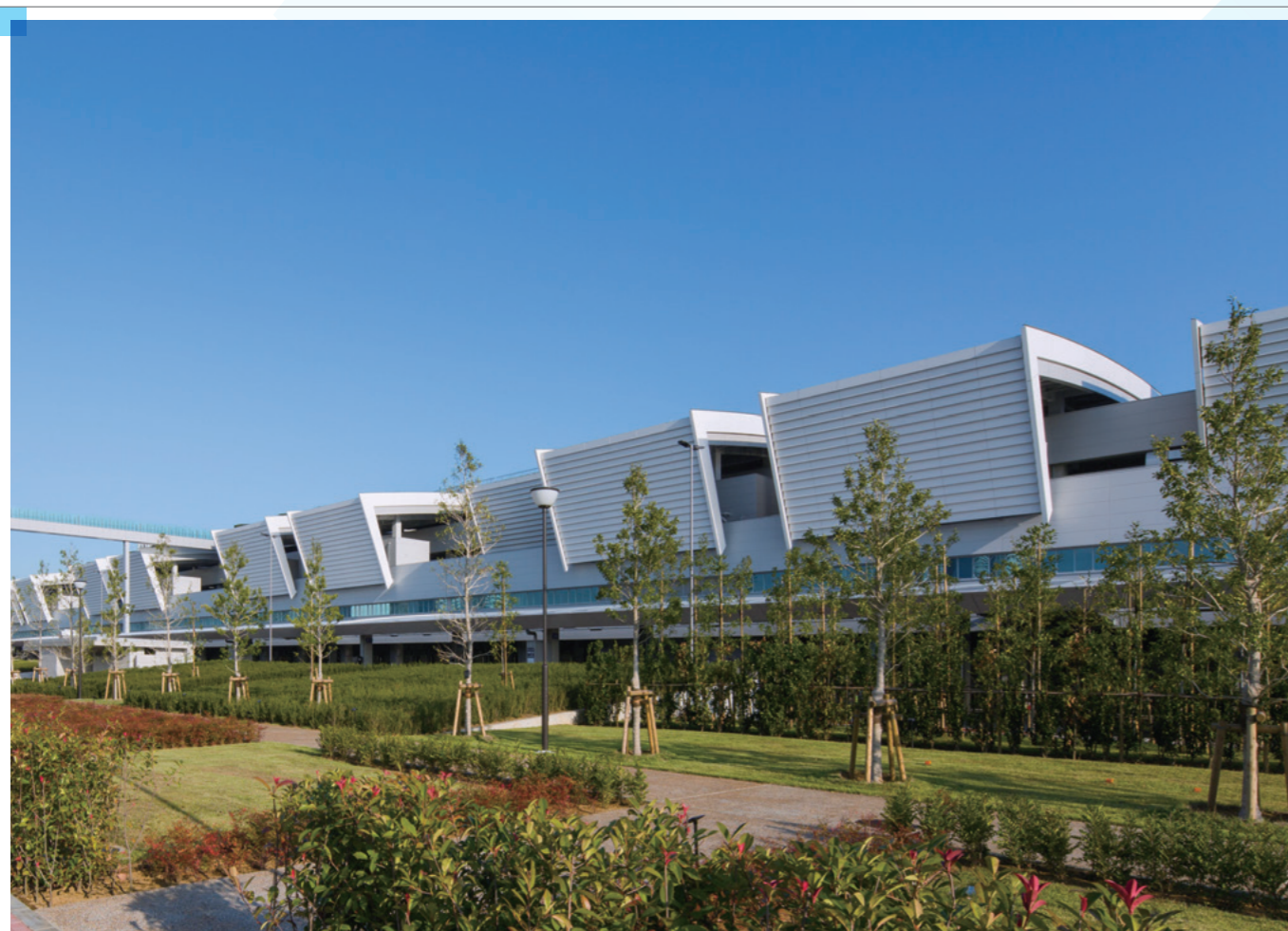
東京都中央卸売市場 豊洲市場水産仲卸売場棟 (工期:2014/06~2016/10)
