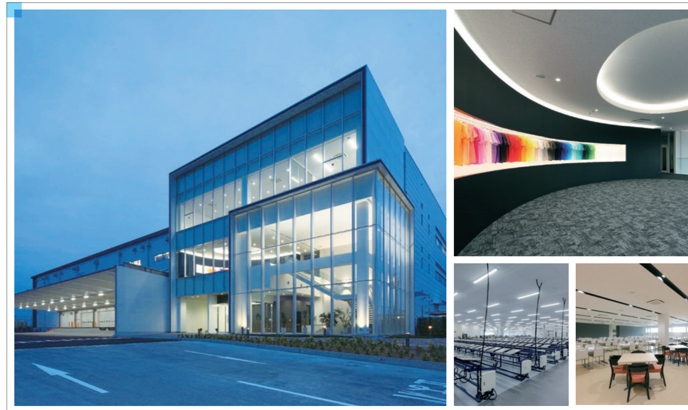
トムス 岐阜本社オペレーションセンター (工期: 2015/04~2016/02)
