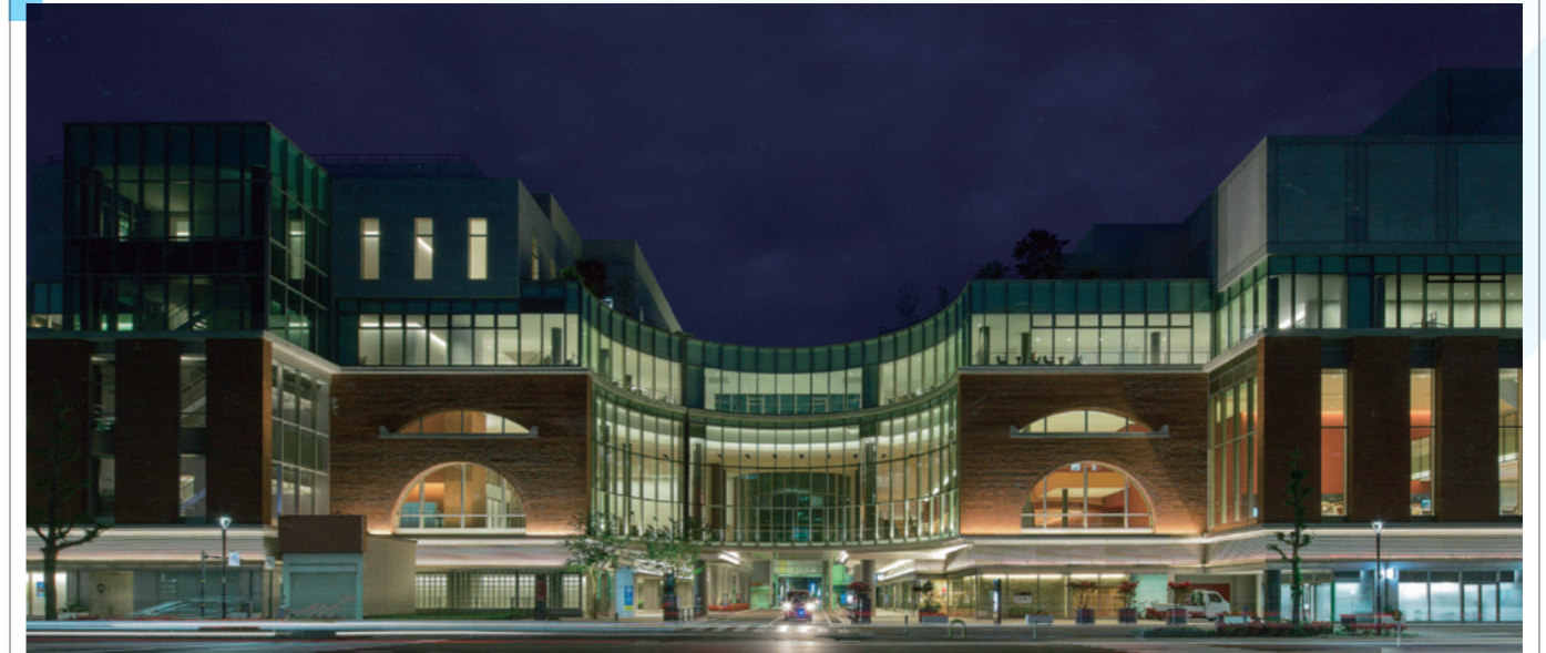
久留米シティプラザ 9番街区 (工期: 2013/09~2015/11)
