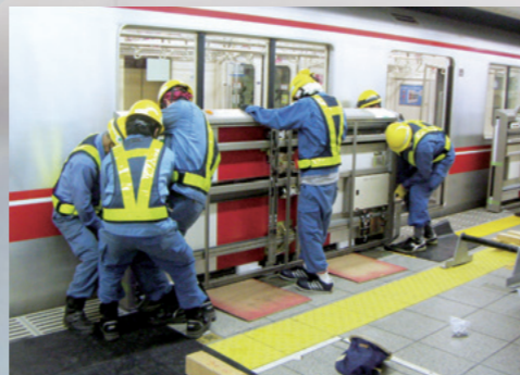
ホームドア据付工事
