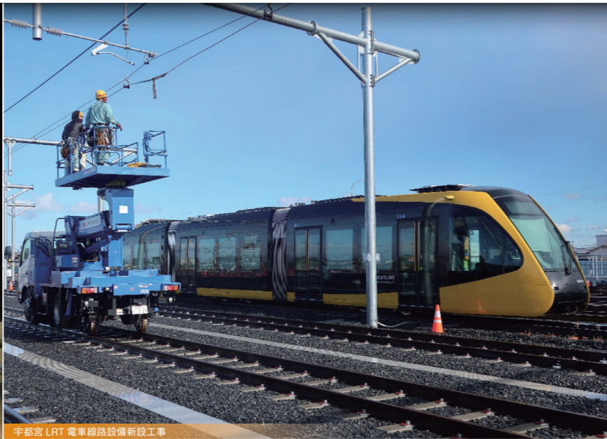
宇都宮 LRT 電車線路設備新設工事
