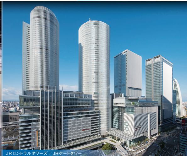
JRセントラルタワーズ / JRゲートタワー
