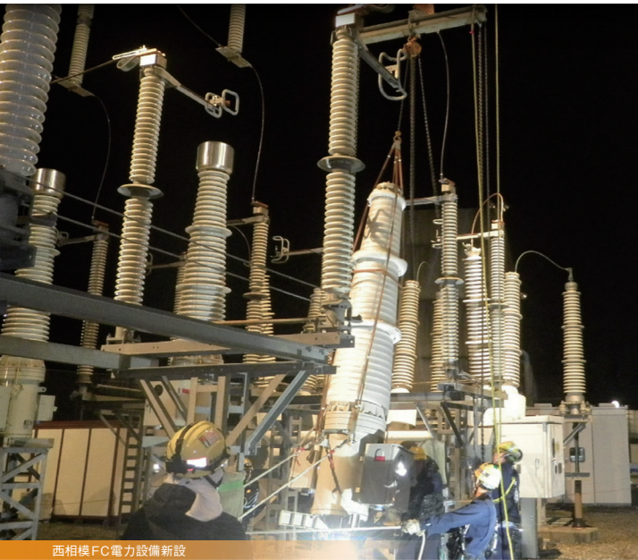
西相模FC電力設備新設
