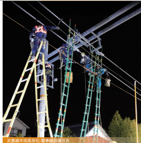
武豊線半田高架化 電車線設備改良
